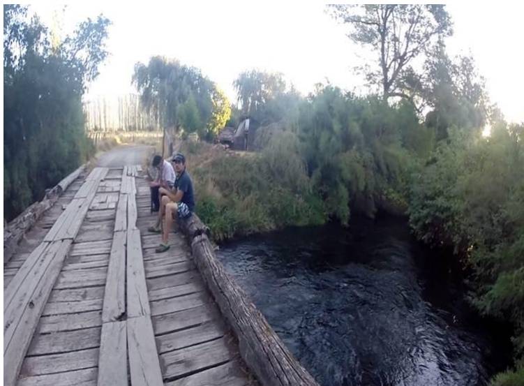
Figura 99. Puente matanza, cercano a la carretera Cunco-Melipeuco.
